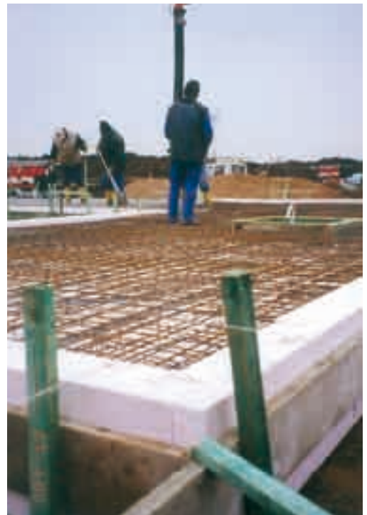
Abb. 16: Dämmung unterhalb der Bodenplatte. Im vorderen Bildbereich ist die Perimeterdämmung zu sehen, die an das Wärmedämmverbundsystem angeschlossen wird.
