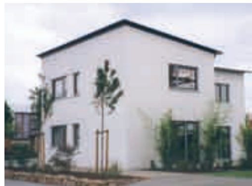
Abb. 36: „Passivhaus“ in Hannover Kronsberg
